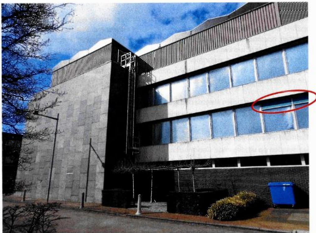
Afbeelding 2: voorbeeld van zonnewering die zich tussen ramen en gevelbekleding bevind.
