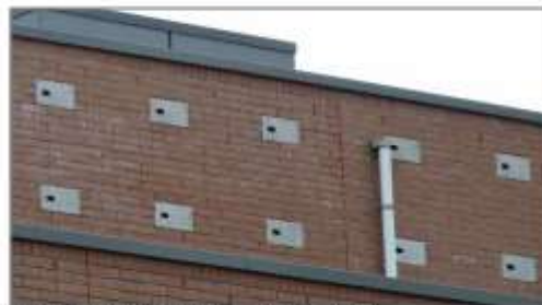
IB GZ 03 of 05 inbouwstenen in een gevel
