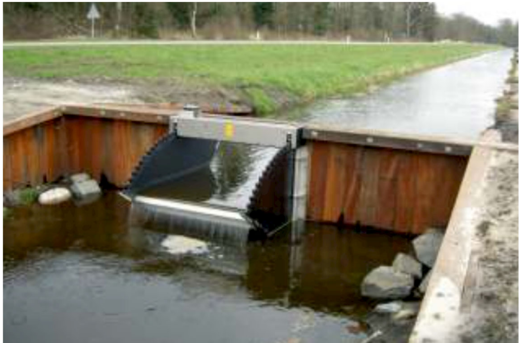
Figuur 2.1 Principe HDPE kantelstuw in houten damwand (bron: KWT Groep)
