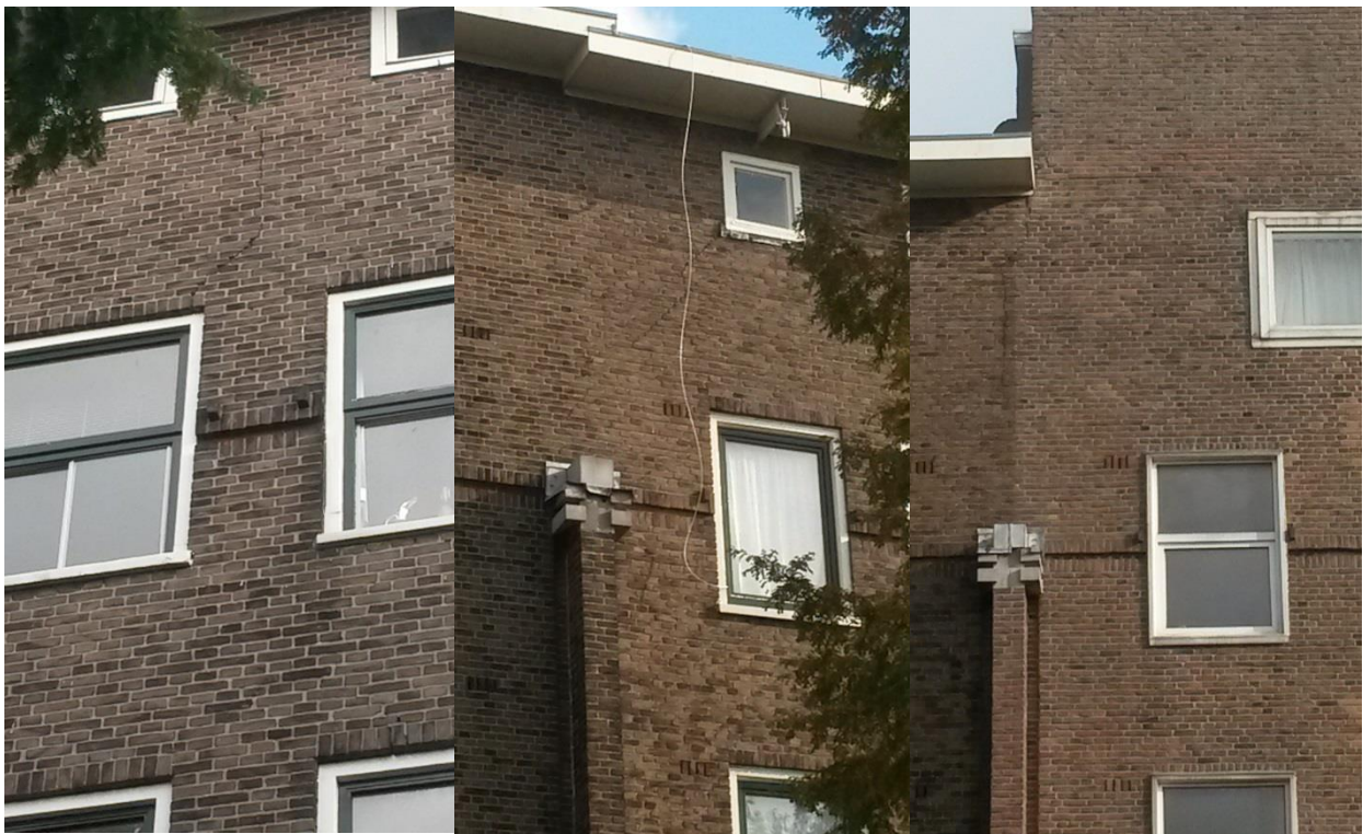
Foto 2-6: waargenomen scheurvorming a/d Molukkenstraat 3 t/m 29
