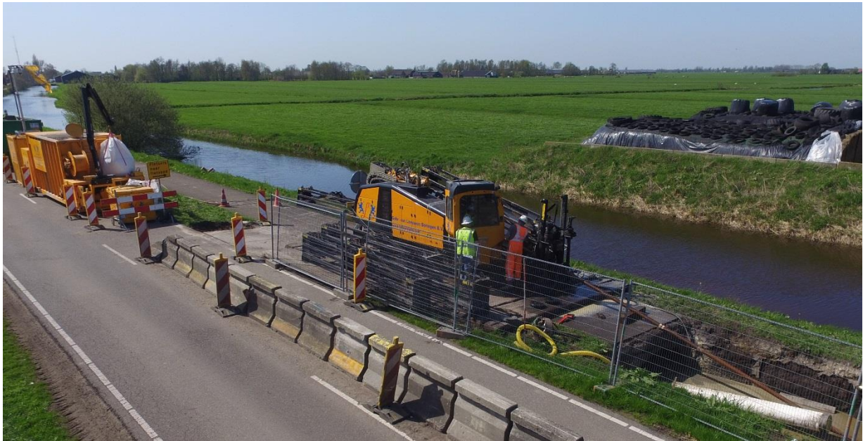
27 ton HDD Drilling rig in Zegveld (NL)
