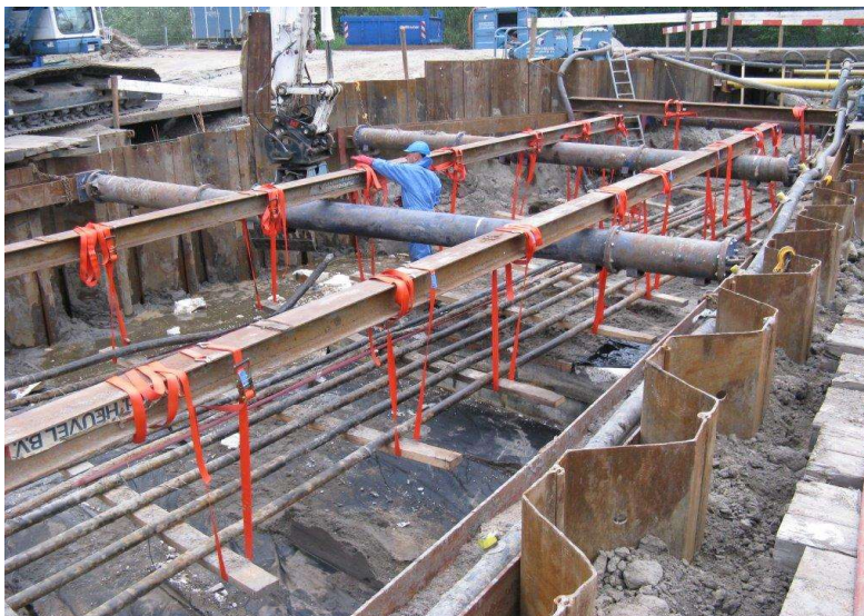
Afbeelding 4: Voorbeeld ophangen van kabels en leidingen
