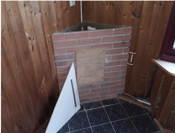
FB01: Woning. De schouw in de woonkamer is uitgevoerd in niet asbestverdacht Fermacell beplating.
