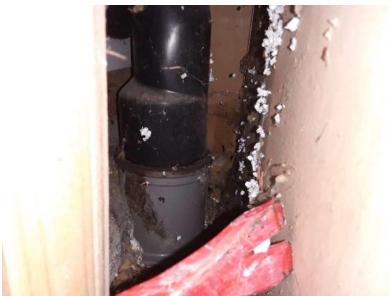
FB04: Woning. In de badkamer is de riolering uitgevoerd in PVC.
