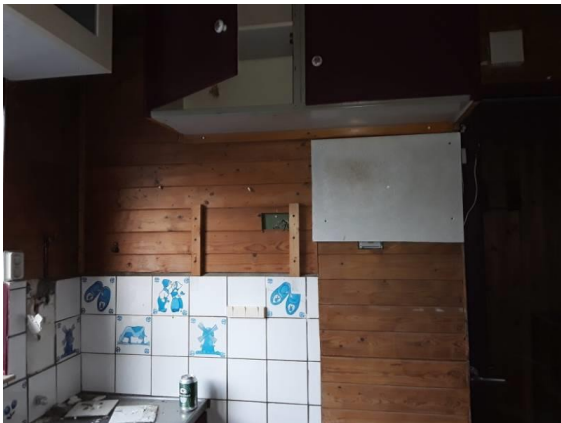
FB02: Woning. In de keuken is een niet asbestverdacht Fermacell plaat tegen de muur gemonteerd.
