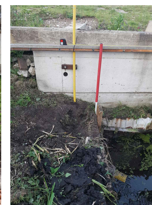
Foto 2, gemaakt bestaande situatie sloot met als uitgangspunt de rode buis als bestaande breedte van 1450mm en de gele buis als de nieuwe breedte van 1750mm.
