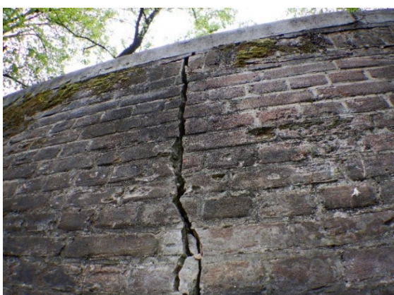
Foto 6: Constructieve scheur in het metselwerk op ca. 27m vanaf het nulpunt.
