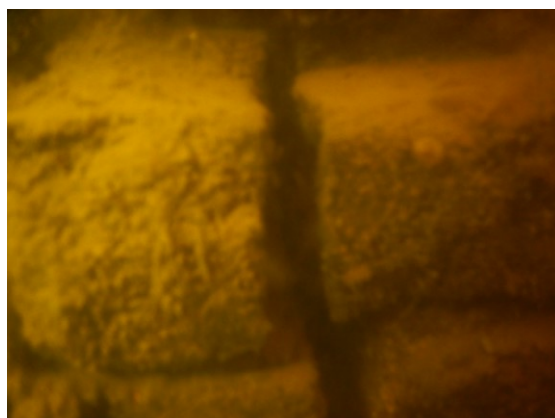
Foto 5: Scheur in de betonnen latei.
