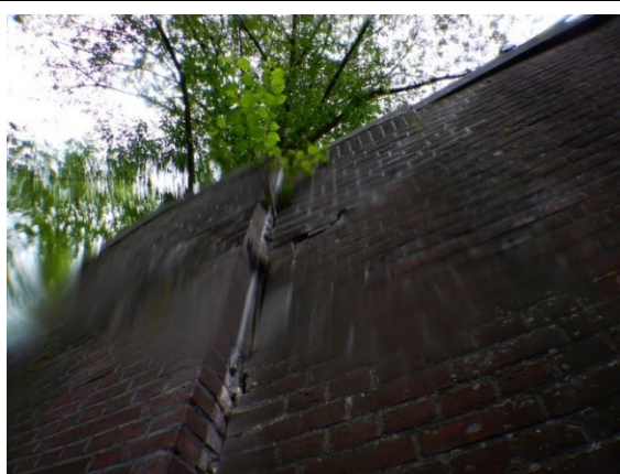
Foto 3: Verpringing van de kademuur bij de dilatatie.
