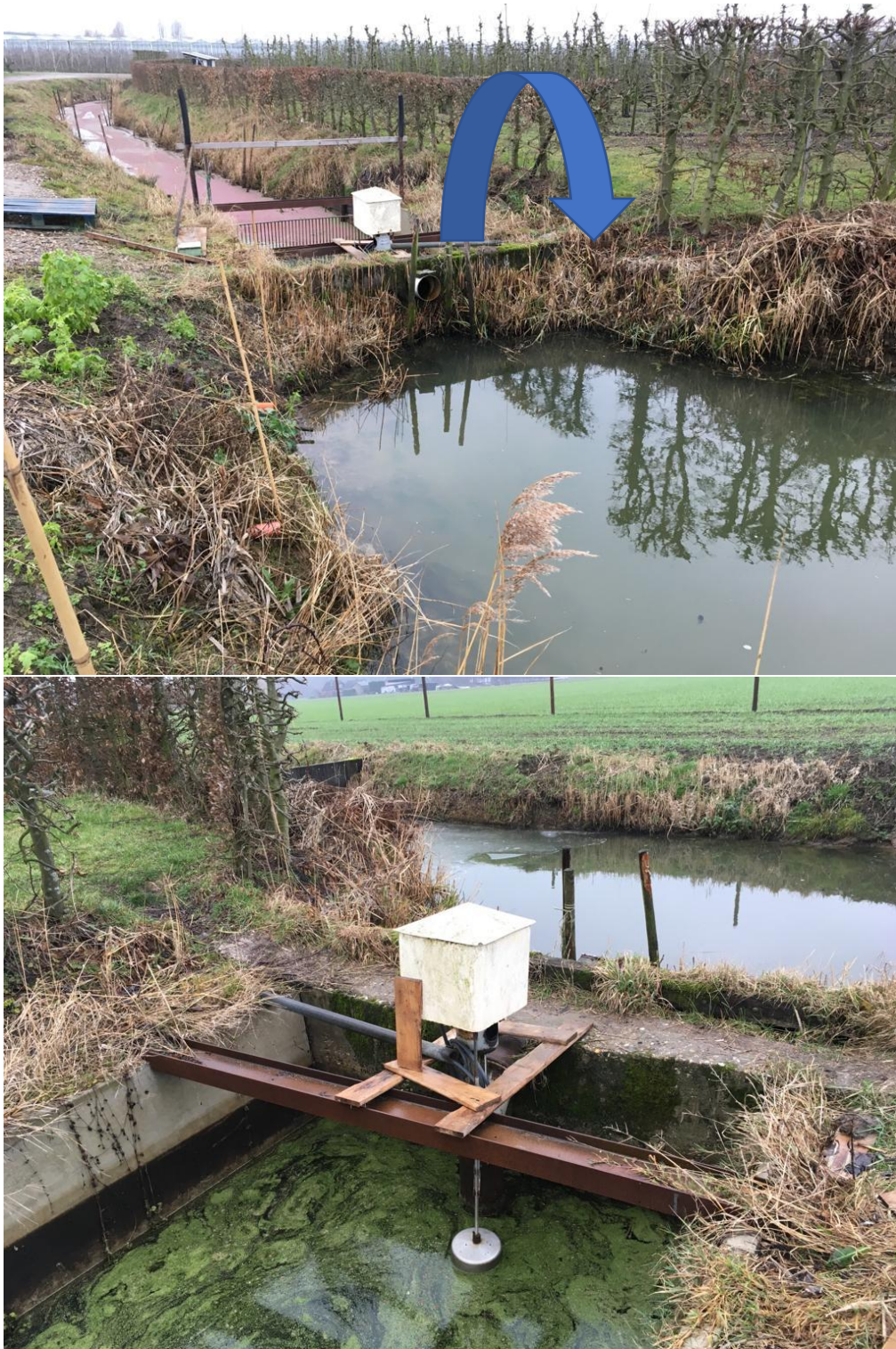
Figuur 3 Stuw met onderbemalingspomp. Drempelhoogte is 123 cm boven NAP. De stuw is bovenlangs 5 meter breed. Debiet van de pomp is 200 kuub per uur. Pomp loodst aan oostkant van de stuw. Pijl laat zien welke kant het water gepompt wordt.
