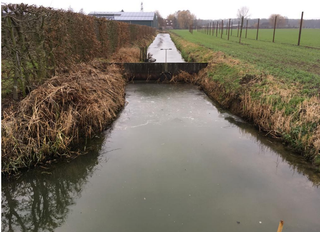
Figuur 2 Stuw met Klep van 50 cm breed. Drempelhoogte is 128 cm boven NAP. De stuw is bovenlangs 8 meter breed.
