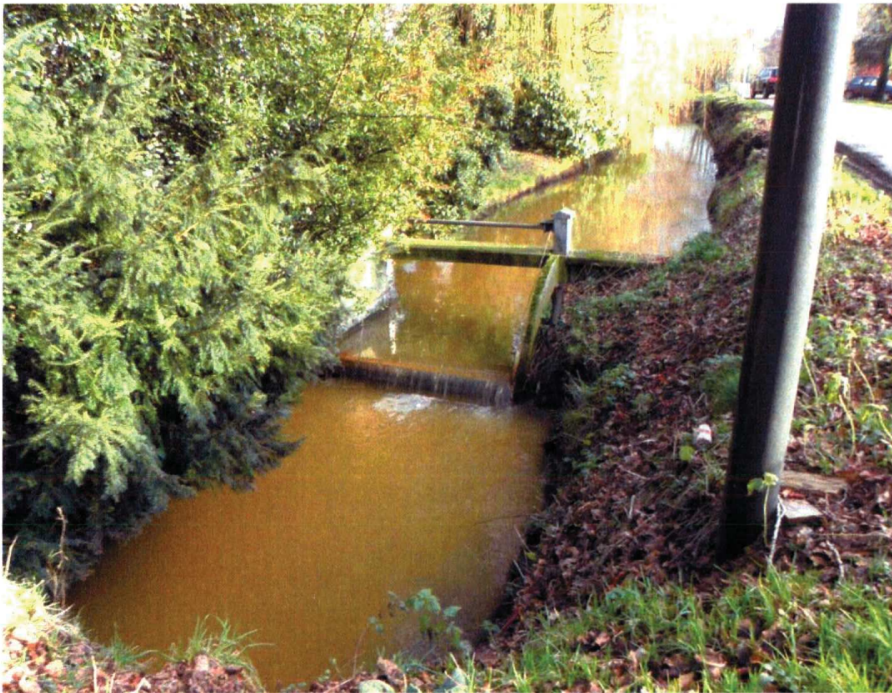
Afvoerstuw die het water afvoert naar het benedenstroomse peilgebied.
