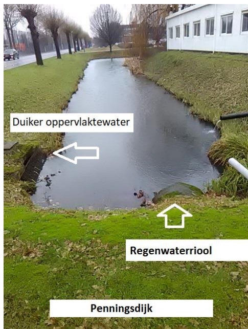
Figuur 6: Foto van ligging duiker en regenwaterriool
