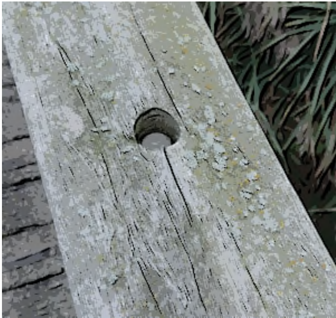
Detail: Bevestiging leuning aan paal.
