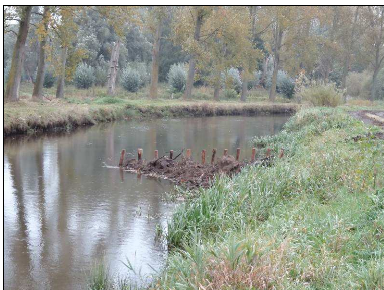
Figuur 2: voorbeeld van een strekdammetje in de Dommel bij Eindhoven (aangelegd januari 2014).
