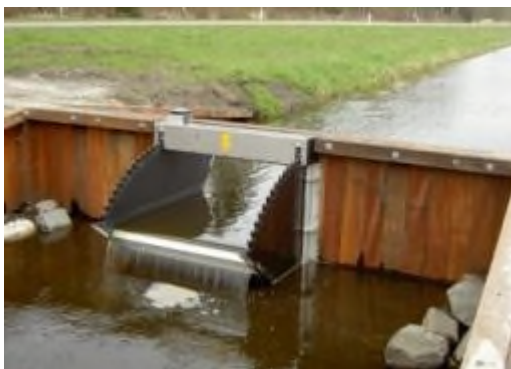
Figuur 12 Voorbeeld stuw (klepstuw) (bron: KWT)
