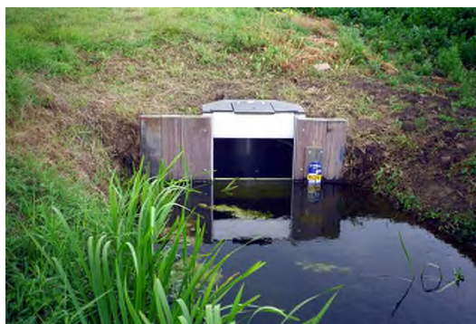
Figuur 9 Voorbeelden stuwput met duiker (bron: HC-Waterbeheersing en KWT)
