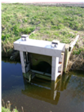
Figuur 9 Voorbeelden stuwput met duiker (bron: HC-Waterbeheersing en KWT)
