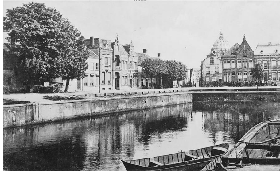
In 1300 werd door Cisterciënzers van de Bernardus abdij de Oudenbossche haven aangelegd. Een bestaande waterweg werd gekanaliseerd en voorzien van een dijk. Aan het einde kwam een zwaairom en een sluis om een scheiding te maken tussen zoet en zout water.
