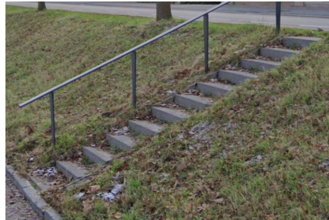
Dijktrappen in beton met eenvoudige leuning
