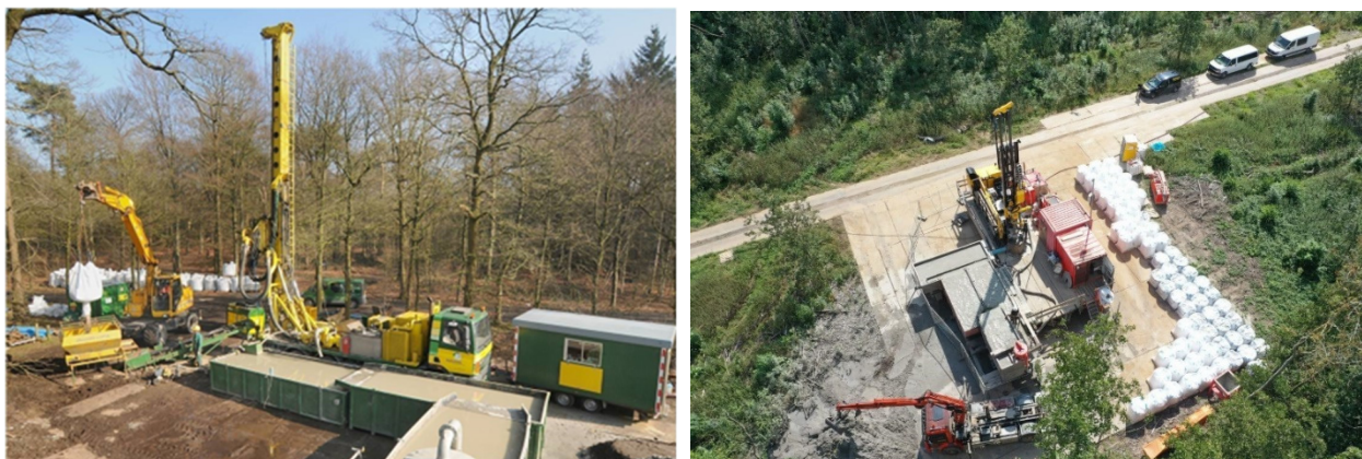
Figuur 3.2 Voorbeeld bouwplaatsinrichting boorstelling
