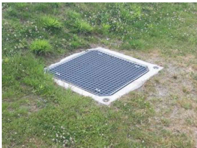
Figuur 11 Voorbeeld inlooppot met maasrooster
