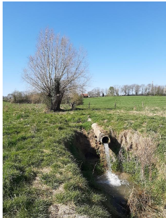
Afbeelding 3 en 4: Huidige situatie stroomafwaarts bij de duiker. Door uitspoeling snijdt de Hondsbönnich zich steeds dieper in (foto R. Hübber).
