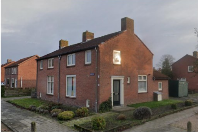
Twee-onder-een-kapwoningen Molenplein 18 en 20 (google Street view, 2021)
