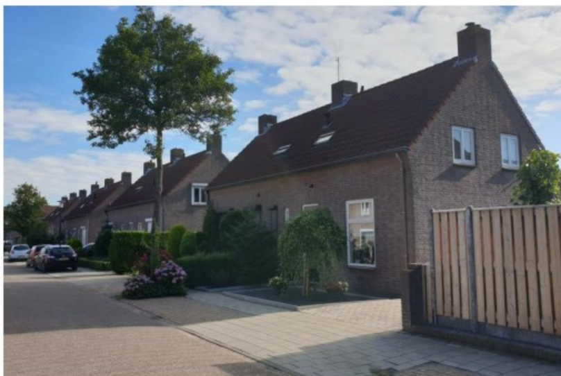
Twee-onder-een-kapwoningen Molenstraat 26 - 40 (even) (google Street view, 2021)
