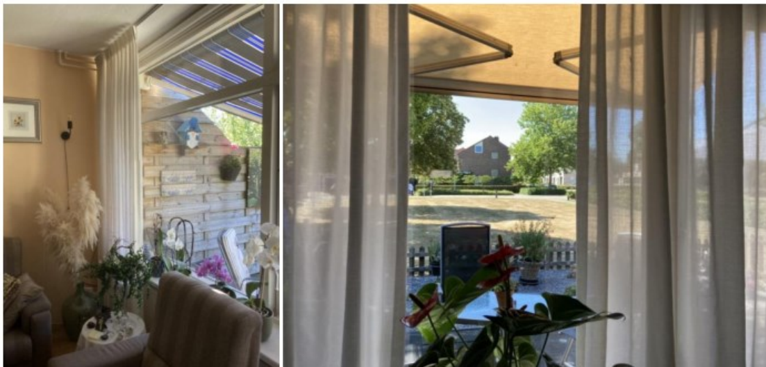
Zonwering is nodig om de hitte buiten te houden. Op de zuidgevel is horizontale zonwering het meest effectief. Bij oost- en westgevel kunnen beter verticale screens worden geplaatst.
