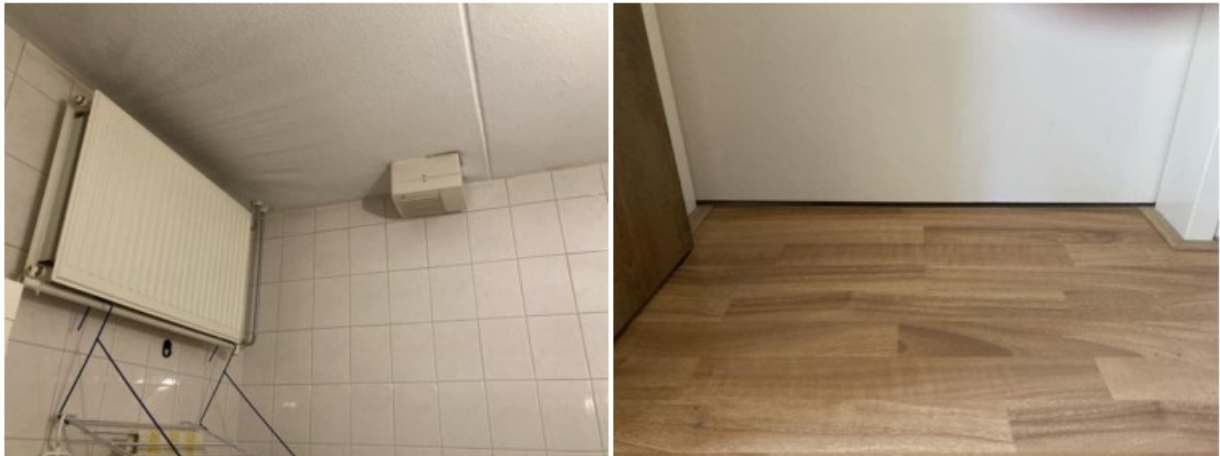
(1) Deze ventilator zuigt voldoende af (2) spleet onder de deur zorgt hier voor voldoende doorstroming.
