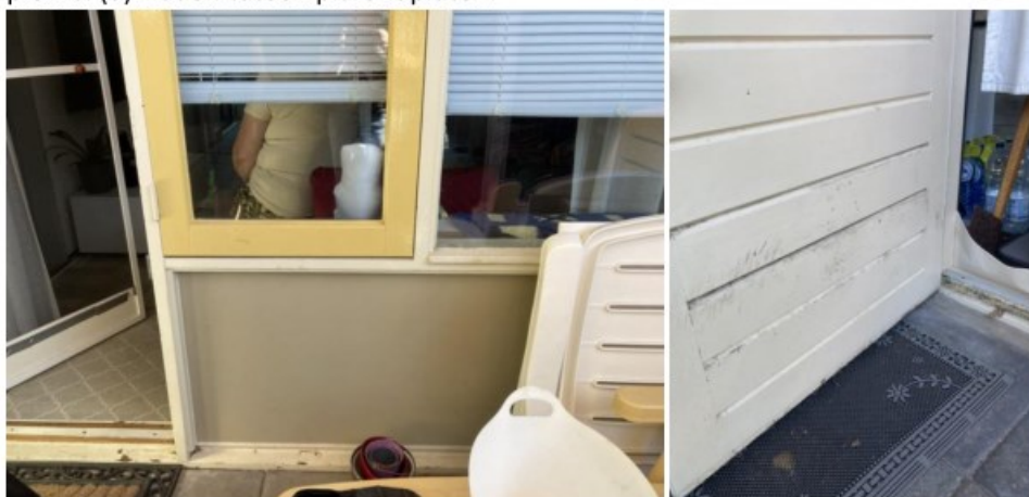
(1) Ongeïsoleerde panelen zorgen voor veel kou (2) deur met schimmel en verouderde tochtrubbers
