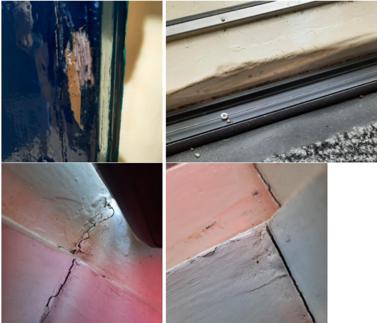
Beschadigd houtwerk
