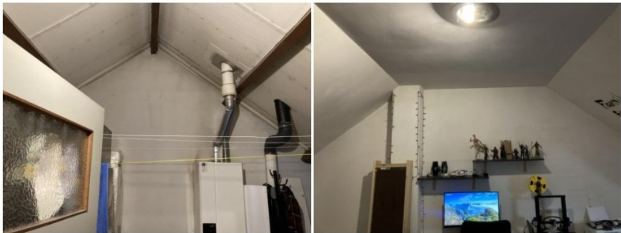
Zolder zonder (L) en met (R) aftimmering. Zo te horen zit er geen isolatie achter de aftimmering
