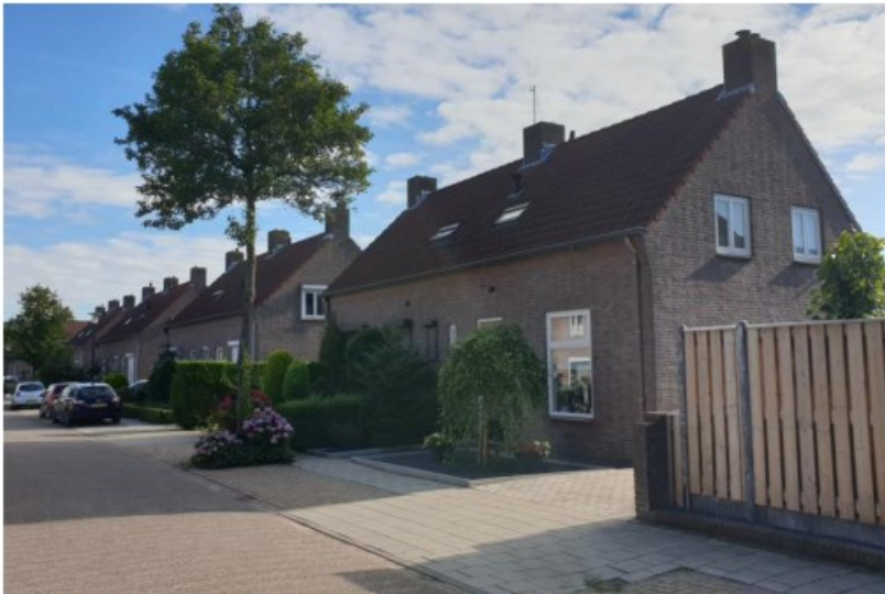
Twee-onder-een-kapwoningen Molenstraat 26 - 40 (even) (google Street view, 2021)
