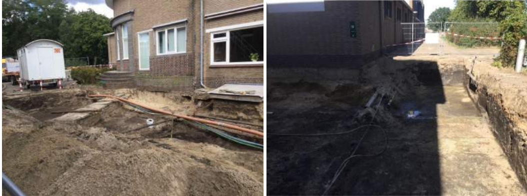
Foto 3 en 4: ontgraven vaste bodem locatie C1 en C2
