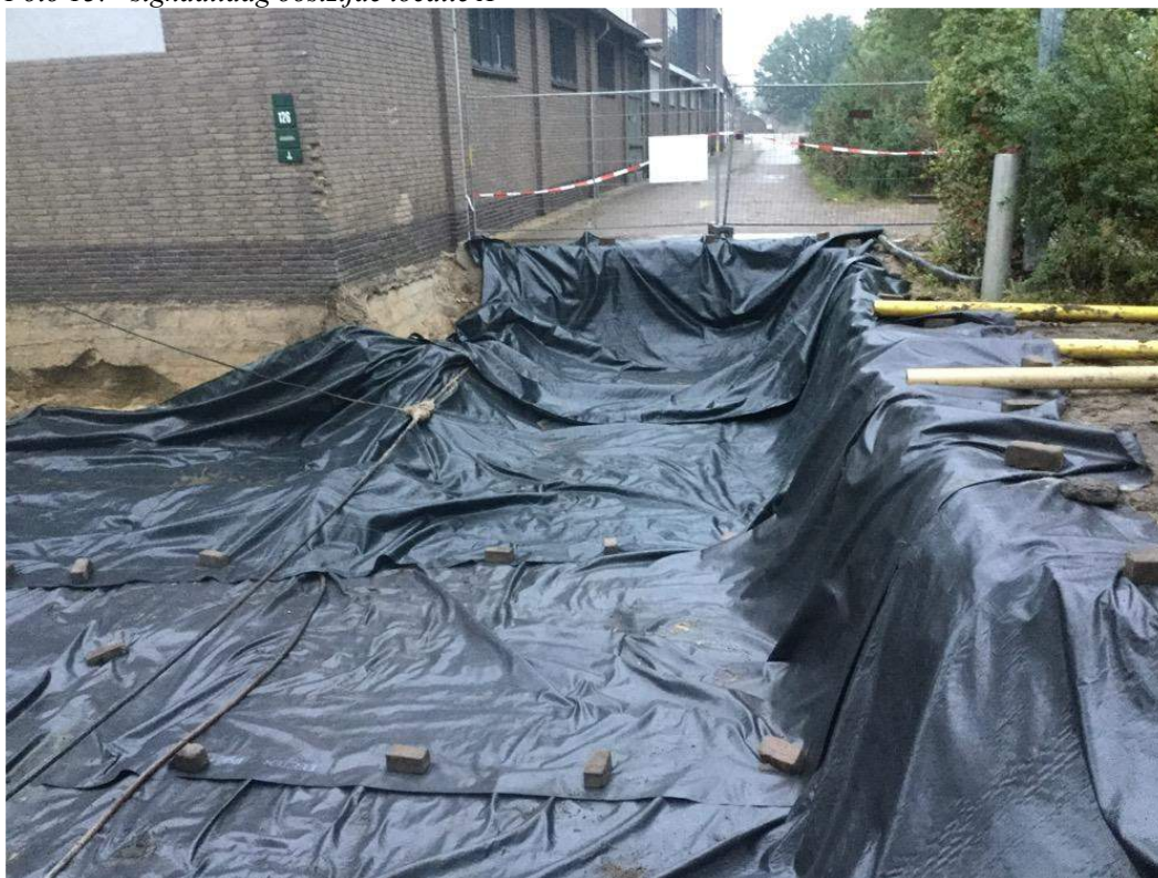
Foto 13: signaallaag oostzijde locatie A
