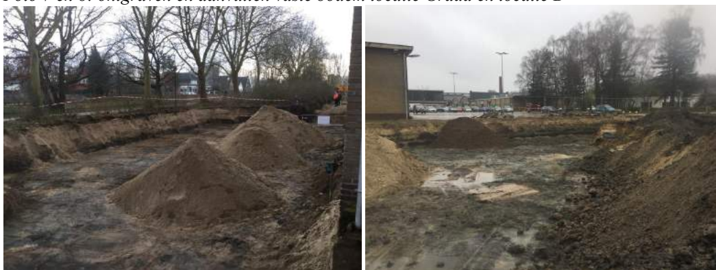
Foto 7 en 8: ontgraven en aanvullen vaste bodem locatie Grada en locatie B
